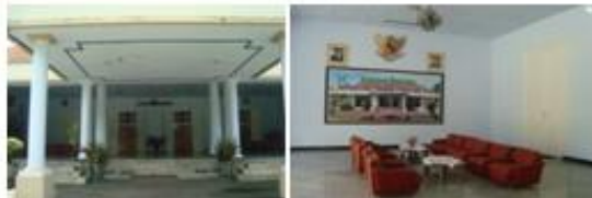
Gambar 6 Teras depan pada bangunan
